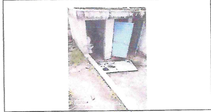
Foto 4: Puertas en mal estado
